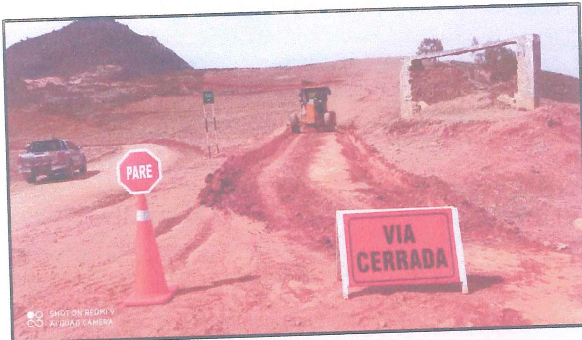
FOTO N°03 Y 04 : VISTA DE TRABAJOS CON MOTONIVELADORA A NIVEL DE SUBRASANTE EN EL CAMINO VECINAL TRAMO: EMP. PE-1NF (HOYADA VERDE) – HOYADA VERDE - EL MAL PASO - EMP. CA-1355 (TANTARICA) - CHUSUC " L= 9.180 km
