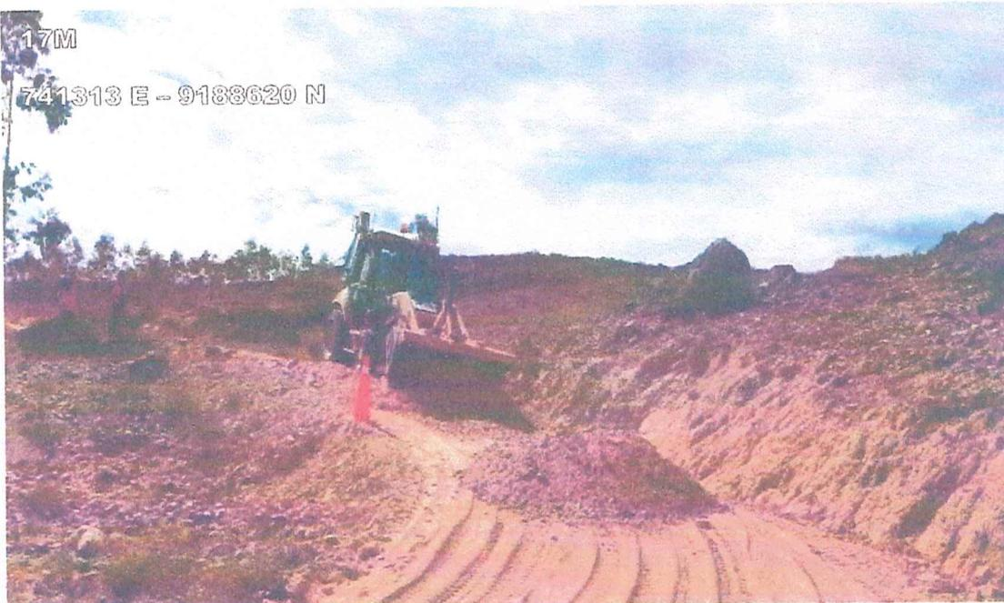
FOTO Nº 10: extendido de material granular con retroexcavadora.
