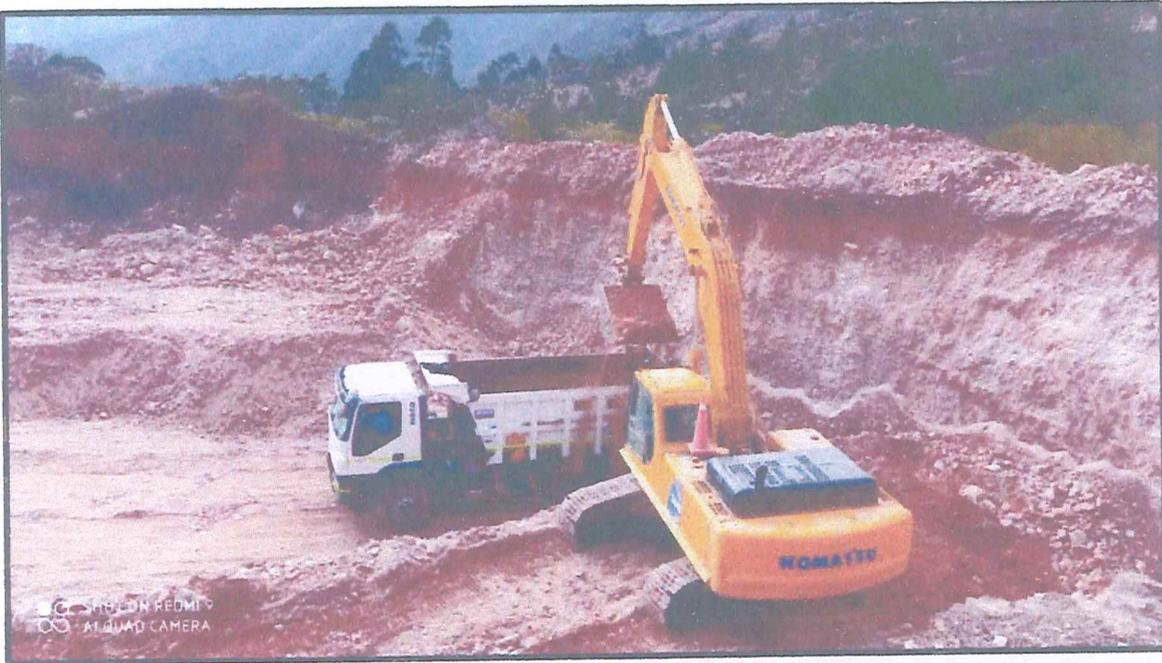
FOTO N°05 Y 06: EXTRACCION Y CARGUIO DE MATERIAL AFIRMADO EN EL CAMINO VECINAL TRAMO: EMP. PE-1NF (HOYADA VERDE) – HOYADA VERDE - EL MAL PASO - EMP. CA-1355 (TANTARICA) - CHUSUC " L= 9.180 km
