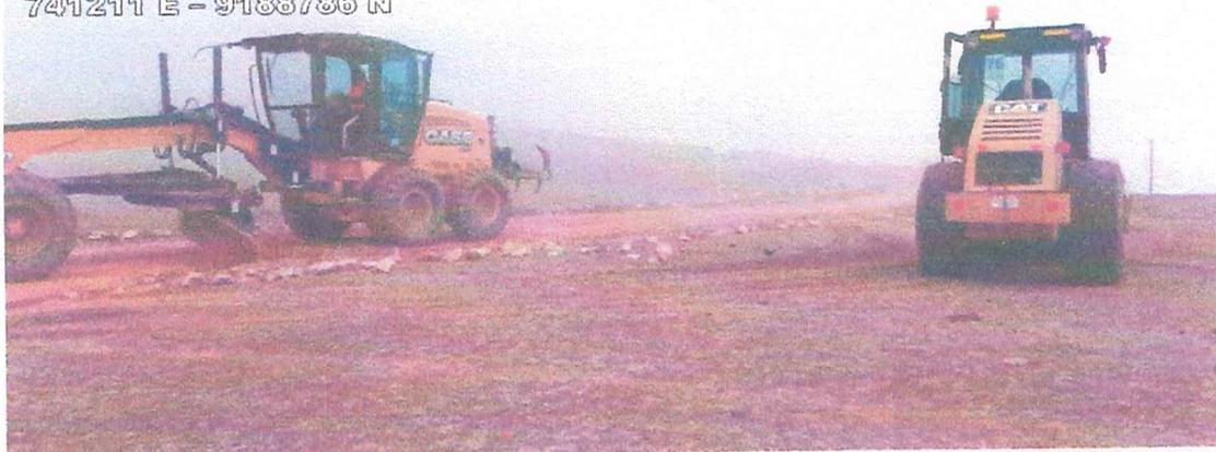
FOTO N° 13: extendido de material granular con motoniveladora.
