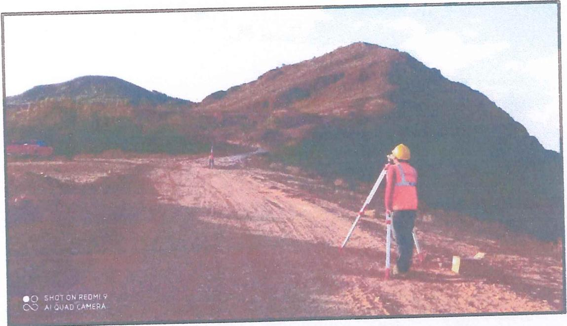
**FOTO N°08:** VERIFICACIÓN Y CONTROL DE LOS NIVELES TOPOGRÁFICOS PARA BASE EN LA EJECUCION DE LOS TRABAJOS EN EL CAMINO VECINAL TRAMO: EMP. PE-1NF (HOYADA VERDE) – HOYADA VERDE - EL MAL PASO - EMP. CA-1355 (TANTARICA) - CHUSUC " L= 9.180 km
